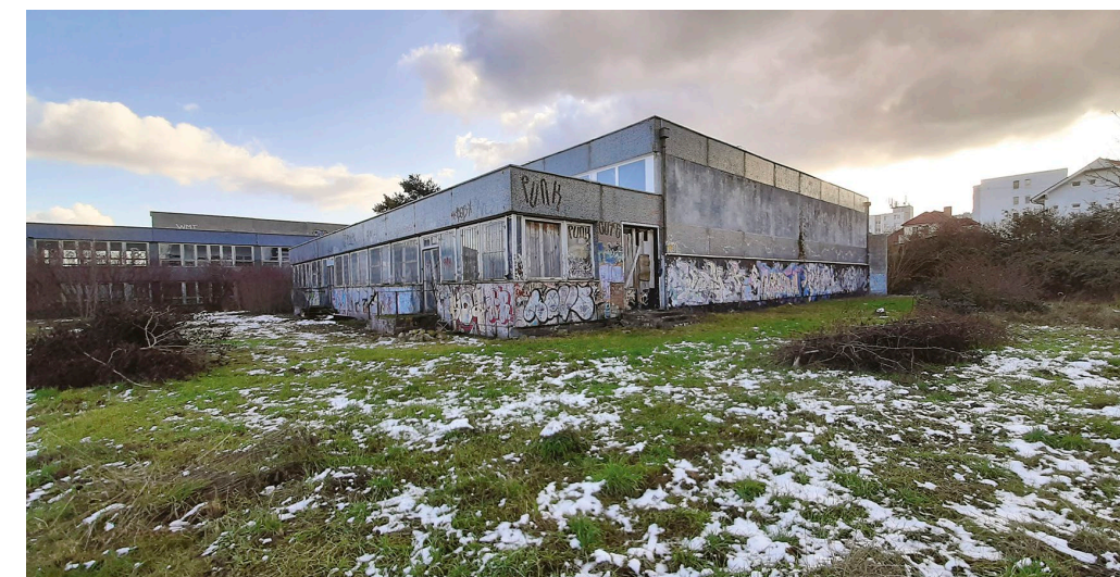
Súčasný stav - exteriér budovy (foto: Ing. Michal Gumenický)
