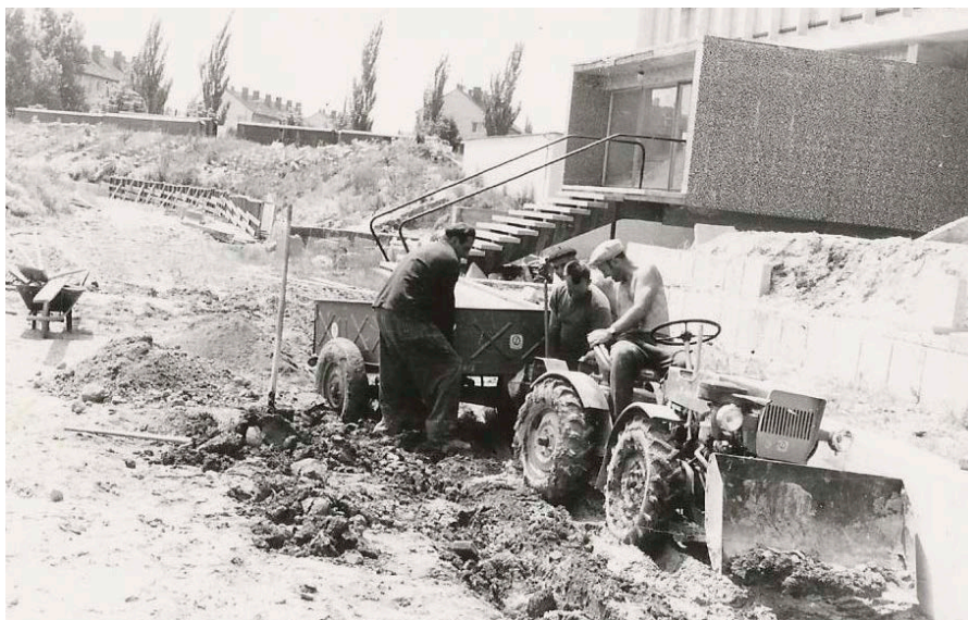
Výstavba futbalového štadióna na Černockého ul. (foto: archív P. Mátuš)
