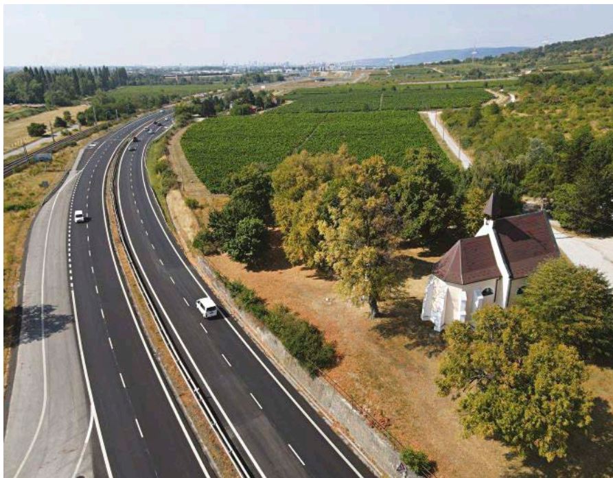
Zrekonštruovaná cesta medzi Račou a Svätým Jurom. Foto: Michal Feik
