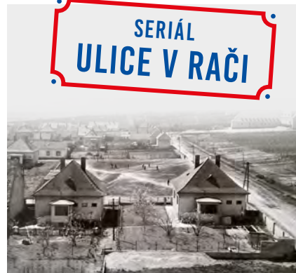
Rača, Čachtická – výstavba domov okolo roku 1935
