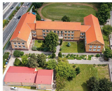
Gymnázium Alberta Einsteina pred rekonštrukciou
